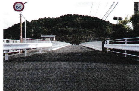
（改修された岩上橋）
